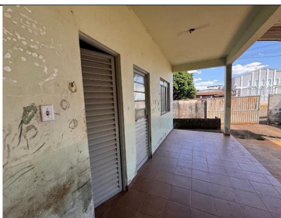
Foto 13 – Vista varanda de laje
